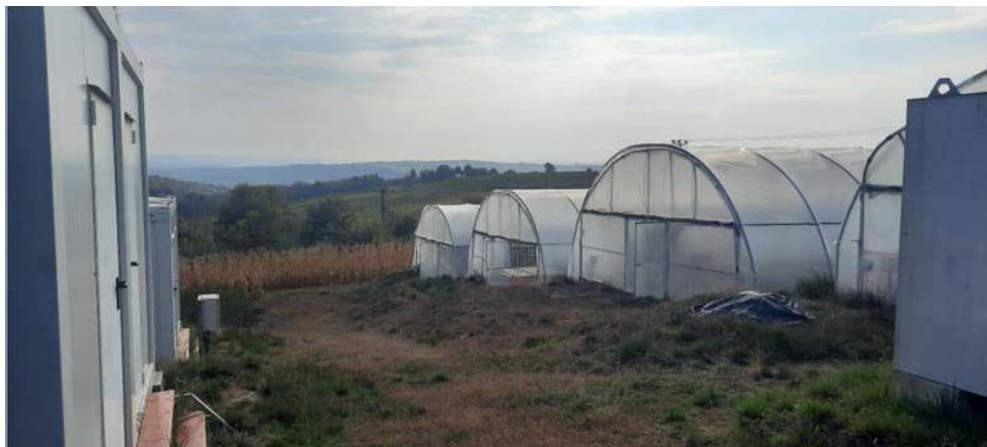
COMPLEXUL DE SOLARII
