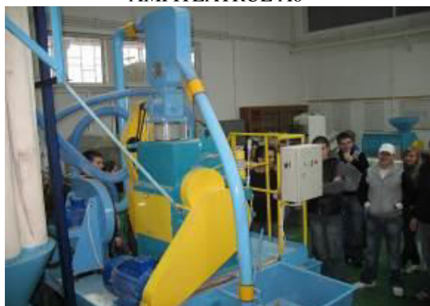
BAZA ENERGETICĂ ȘI MECANIZARE
